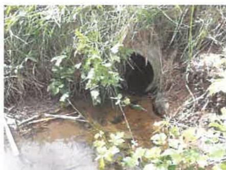
Busage du cours d'eau (sous l'accès agricole) avant la confluence
