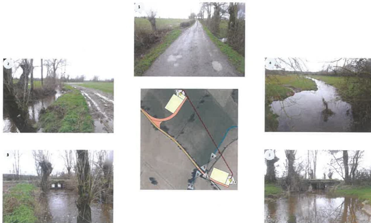
Figure 230 : Localisation et illustrations du ruisseau de la Mare aux Canes au niveau d'un ouvrage de franchissement sous une voirie renforcée pour l'accès à l'éolienne E4 (photos prises au cours de l'hiver 2019-2020 particulièrement pluvieux)
